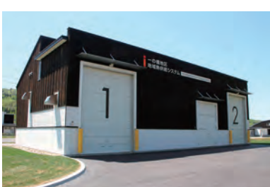
木質バイオマスボイラー導入施設の一つ
